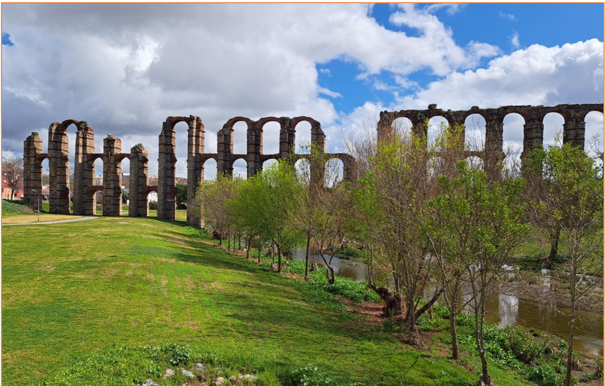
Acueducto de los Milagros
